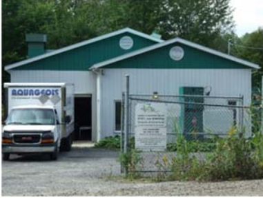
Centre de transfert des RDD à Rawdon
